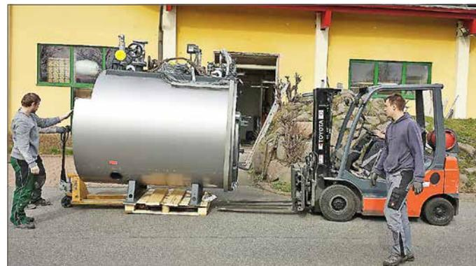
Das ist Millimeterarbeit: Der Türrahmen zum Kesselraum musste entfernt werden, erst dann passte der Kessel hindurch.
