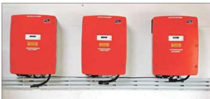
Drei Wechselrichter wandeln den durch die Solaranlage erzeugten Gleichstrom in einen mit dem Versorgungsnetz kompatiblen Wechselstrom.
